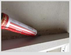
Dichten Sie nun den Übergang von Fenster und Ortbetonwand mit HIEBER-Dicht ab
