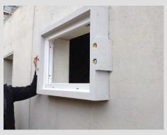
Nach der Montage können Sie die Perimeterdämmung an der Wand anbringen
