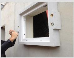
CombiTherm Dämmelement mittels zwei Schrauben an der Betonzarge anschrauben
