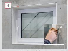
Vor Montage der Dämmschale muss die Wand auf Unebenheiten kontrolliert und evtl. nachgearbeitet werden. Öffnen der Kunststoffabdeckung (grauer Verschlussstopfen an Betonzarge siehe Abb. a).
