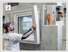
Dämmschale mittels 2 Schrauben an Betonzarge anschrauben.
