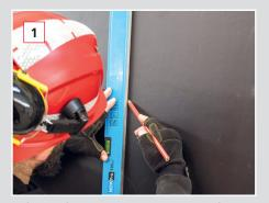
Auf der Außenschalung Position des Kellerfensters IsolaMENT<sup>3</sup> (Stützrahmen) einmessen. Wasserwage verwenden.
