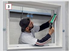
Kombriband oder eine dauerelastische Fuge (z.B. HIEBER®Dicht weiß) zwischen der Stirnseite der Dämmschale und dem Fensterrahmen anbringen. Dämmschale umlaufend gegen sickerndes Regenwasser abdichten z.B. mit HIEBER®Dicht.
