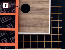
Nach dem Zuschalen ist der Rahmen von innen zusätzlich gegen Auftrieb anzunageln bzw. anzuschrauben.
